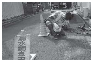
▲漏水確認作業
